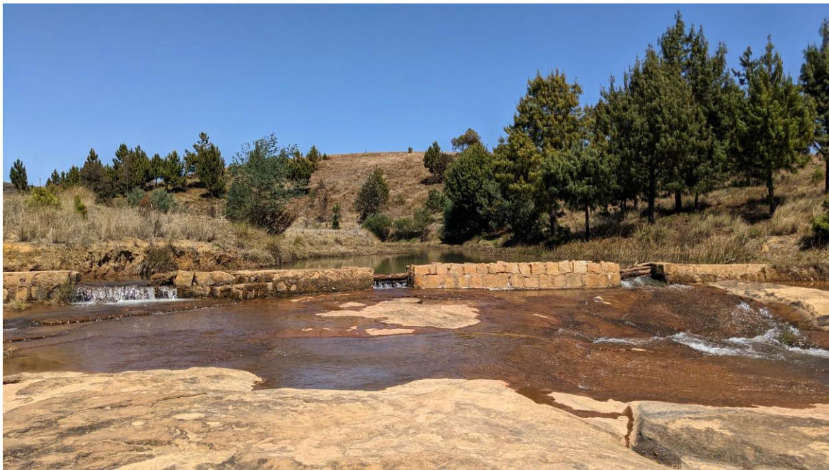
Figure 1 Vieux barrage d'Ankazondrano
