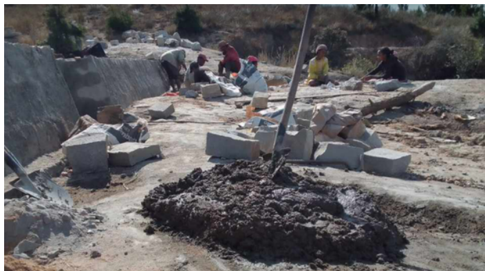
Préparation de mortier pour le barrage d'Ankazondrano Les moellons sont fournis par la population locale.
