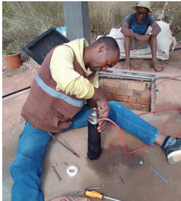
Réparation de pompe solaire en panne.
