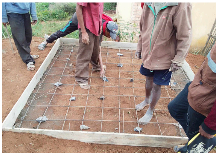
Fabrication de la base d'un reservoir
