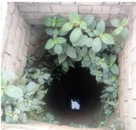
Puits avec parement en brique
